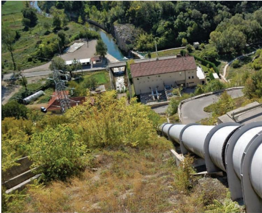
Slika 2.9. Derivacijsko-protočna HE Peć Mlini [8]
