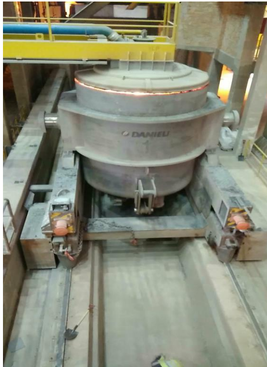
Sl.3.1. Kolica s loncem smještena na tračnice
