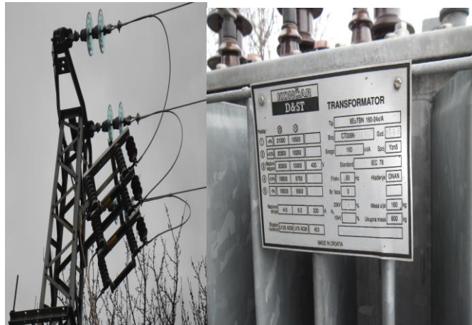
Sl.4.2.Željezna trafostanica sa visokonaponskim osiguračima i transformatorom
