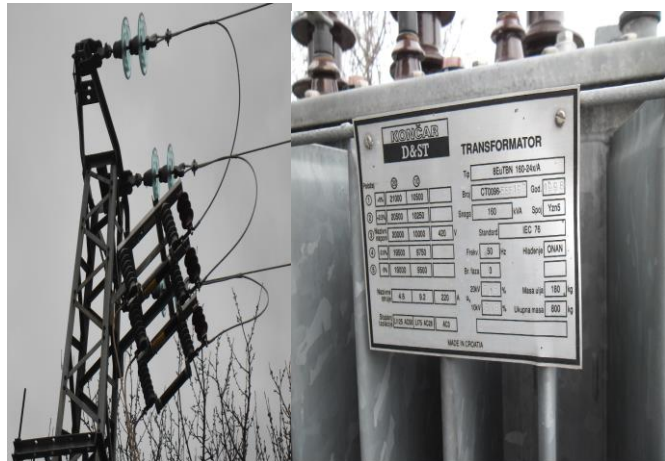
Sl.4.2.Željezna trafostanica sa visokonaponskim osiguračima i transformatorom
