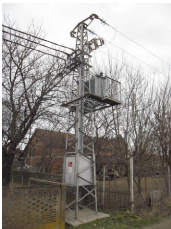
Sl.4.2.Željezna trafostanica sa visokonaponskim osiguračima i transformatorom
