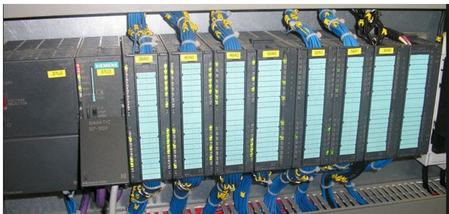
SI 3.1.1. Programabilni logički kontroler. [13]
