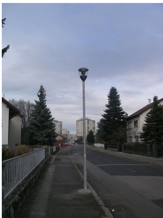
Slika 4.4. Novi rasvjetni stup u Čakovcu[8]
