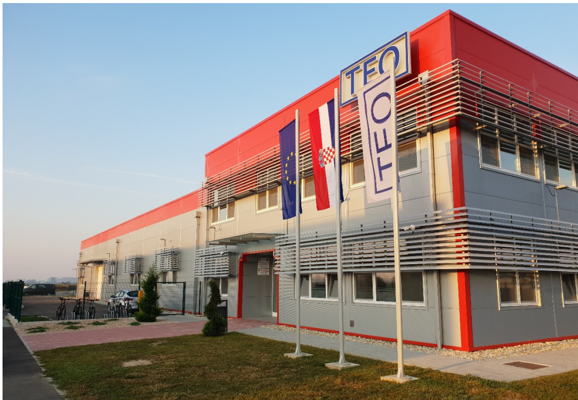
Slika 3.12. Zgrada koja je korištena u istraživanju
