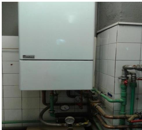
**Slika 6.2.** Prikazuje plinski kombi bojler koji je korišten za grijanje i potrošnu toplu vodu na obiteljskoj kući.
