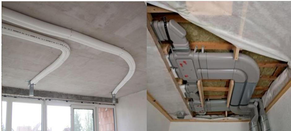
**Slika 4.8.** Položaj zračnih kanala u stambenoj zgradbi i primjer odsisnih kanala za zrak. Kanali za zrak su bitan dio investicije i potrebno je strojarsko iskustvo u projektiranju kanala kako ne bi došlo do čestih mehaničkih kvarova, [18].
