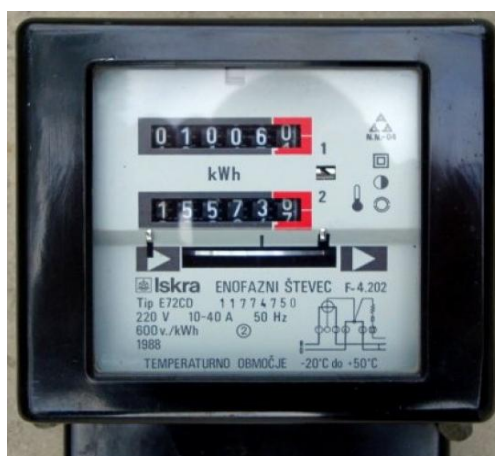
Slika 3.5. Prikaz jednofaznog dvotarifnog brojila proizvođača Iskra
