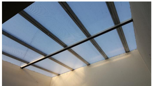
Slika 4.16. Karakteristični otvor zgrade M-JED (svjetlarnik stubišta).
