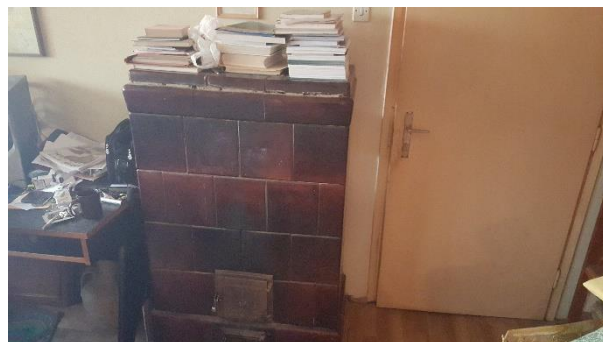
Slika 4.28. Kaljeva peć.
