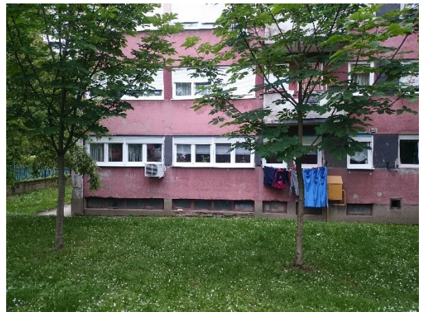
Slika 4.4. Zapadno pročelje zgrade.
