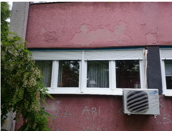
Slika 4.17. Karakteristični otvor zgrade PVC-IZO (prozor stambenog prostora).
