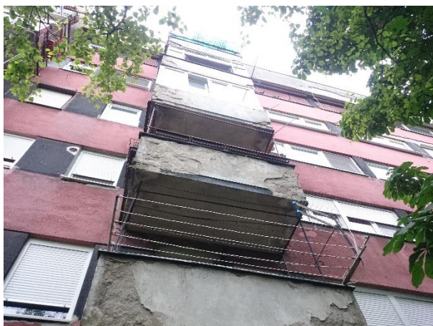
Slika 4.25. Oštećenja balkona.
