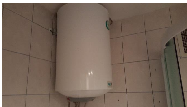
Slika 4.32. Jedan od električnih bojlera.
