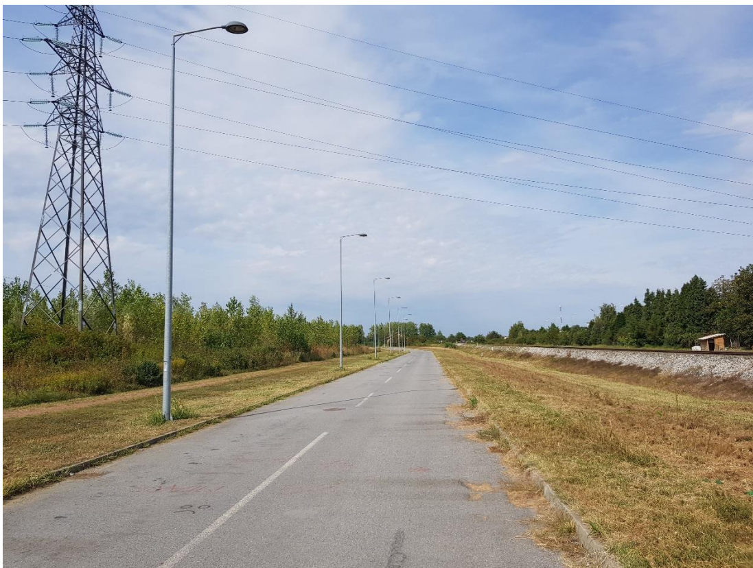
Slika 4.2. Jednostrani raspored svjetiljki sa SRS 2B stupovima.
