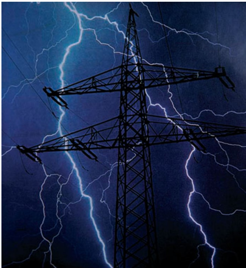
Slika 3.6. Udar groma u blizini dalekovoda [3]
