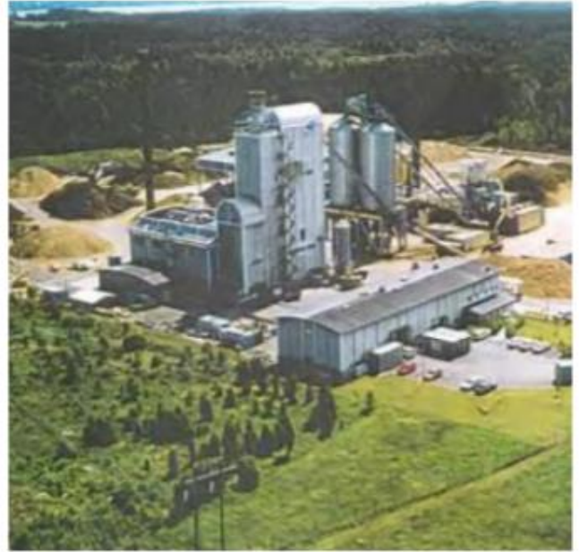
Finska kogeneracija VN, 49 (167) MW
