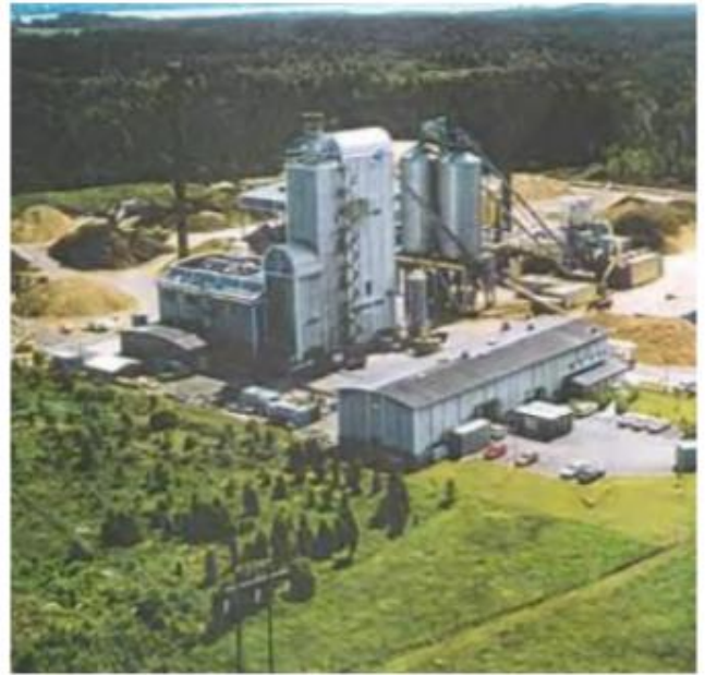
Finska kogeneracija VN, 49 (167) MW
