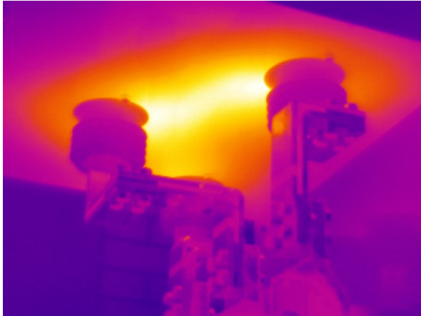
Slika 7.7. IR slika prolaza spojnih sabirnica kroz provodnu ploču
