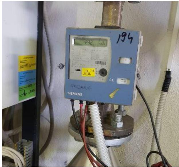
Slika 5.1. Kalorimetar Siemens RVD250.
