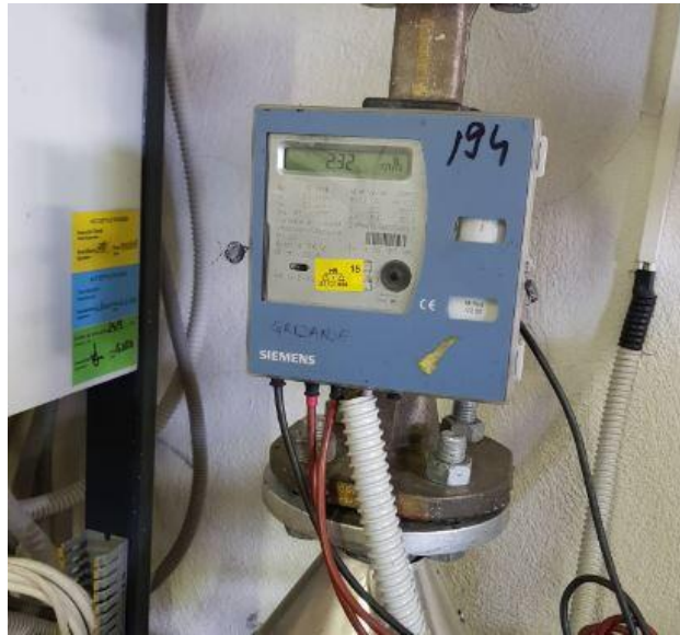
Slika 5.1. Kalorimetar Siemens RVD250.
