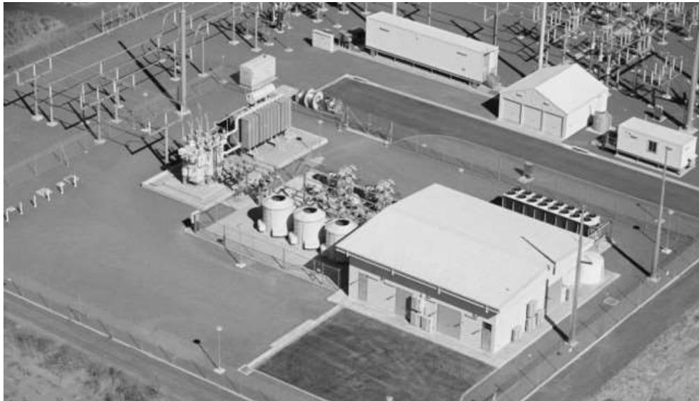
Slika 19.2 SVC postojenje – zračni snimak
