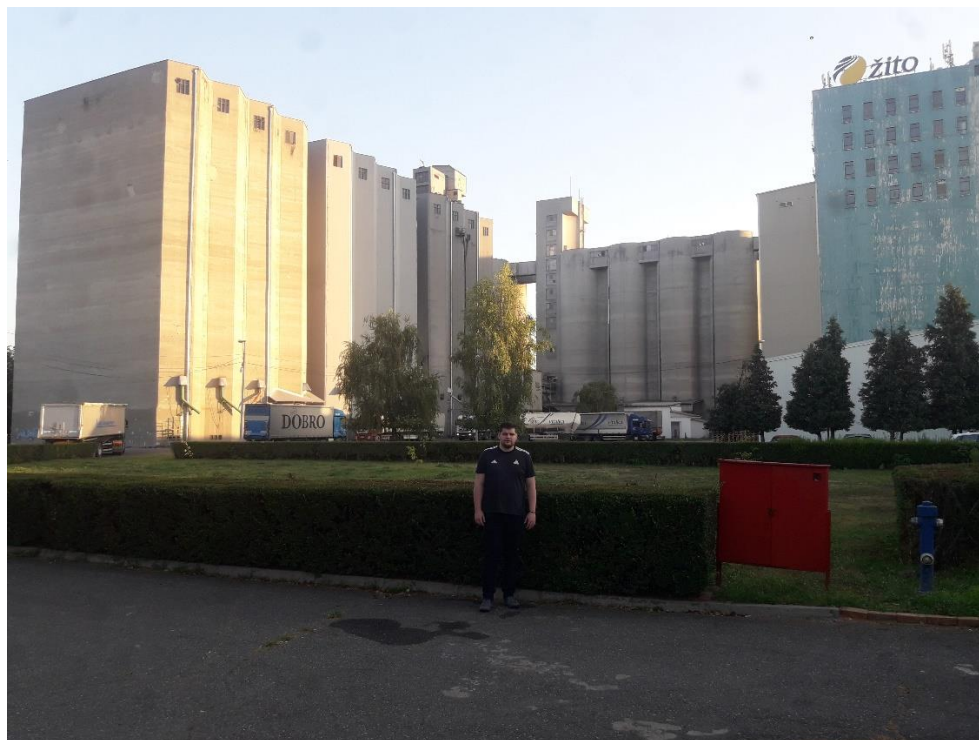
Slika 3.18. Silosi Osijek Žito d.o.o.
