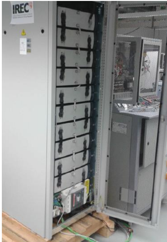
Slika 2.11. Litij-ionski baterijski sklop u IREC laboratoriju[1]
