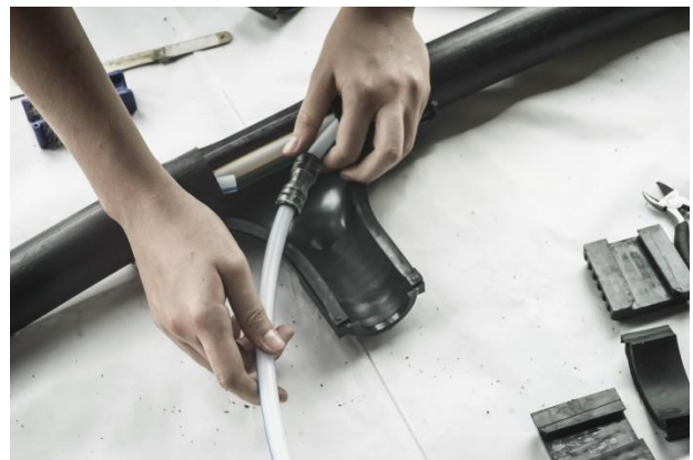
Slika 5.17: Spajanje mikrocijevi konektorom za mikrocijevi
