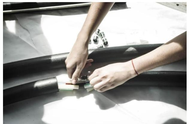
Slika 5.6: Spajanje mikrocijevi konektorima za mikrocijevi
