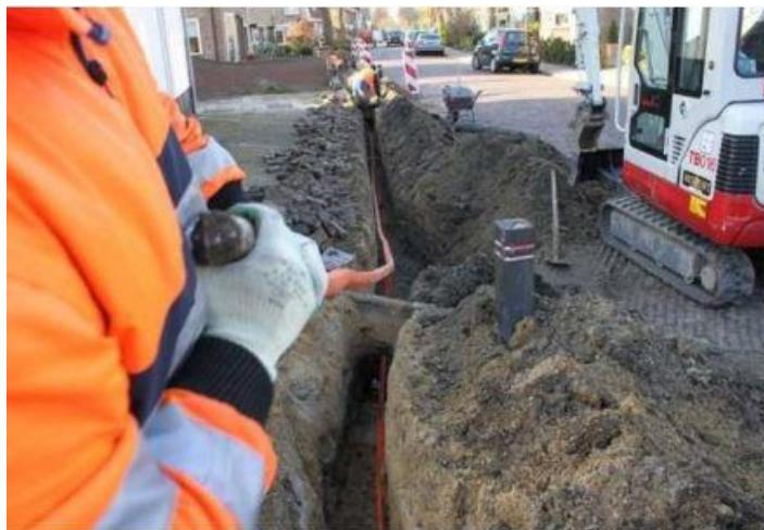
Slika 4.21: Polaganje mikrocijevne strukture [25]
