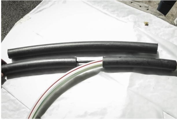
Slika 5.3: Snop mikrocijevi uvučen u jednu stranu cijevi
