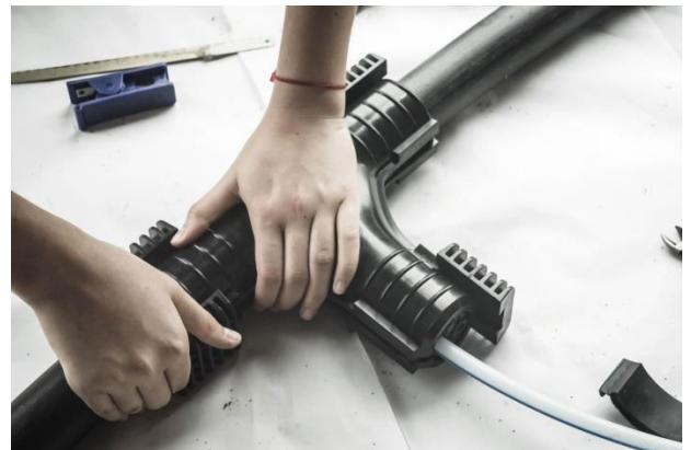
Slika 5.19: Zatvaranje T konektora
