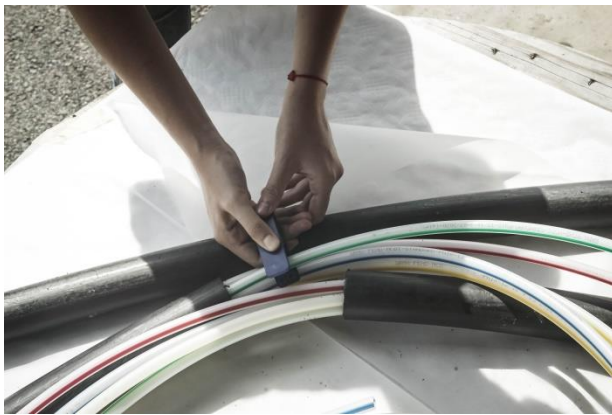
Slika 5.5: Skraćivanje mikrocijevi
