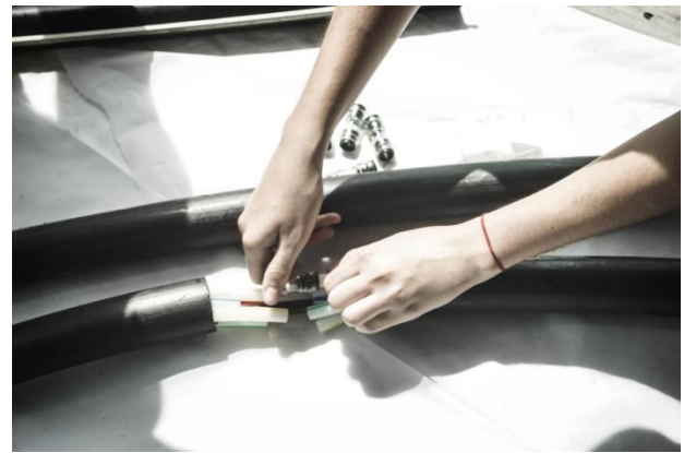
Slika 5.6: Spajanje mikrocijevi konektorima za mikrocijevi
