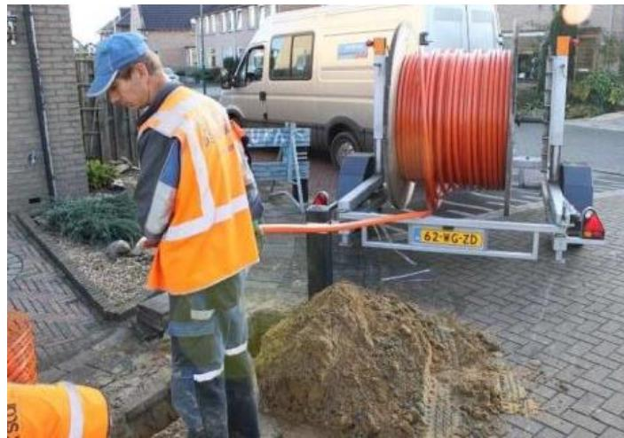
Slika 4.20: Odmotavanje mikrocijevne strukture [25]
