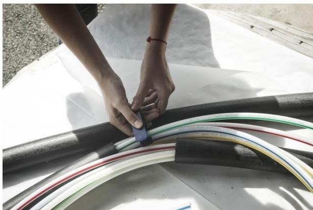
Slika 5.5: Skraćivanje mikrocijevi
