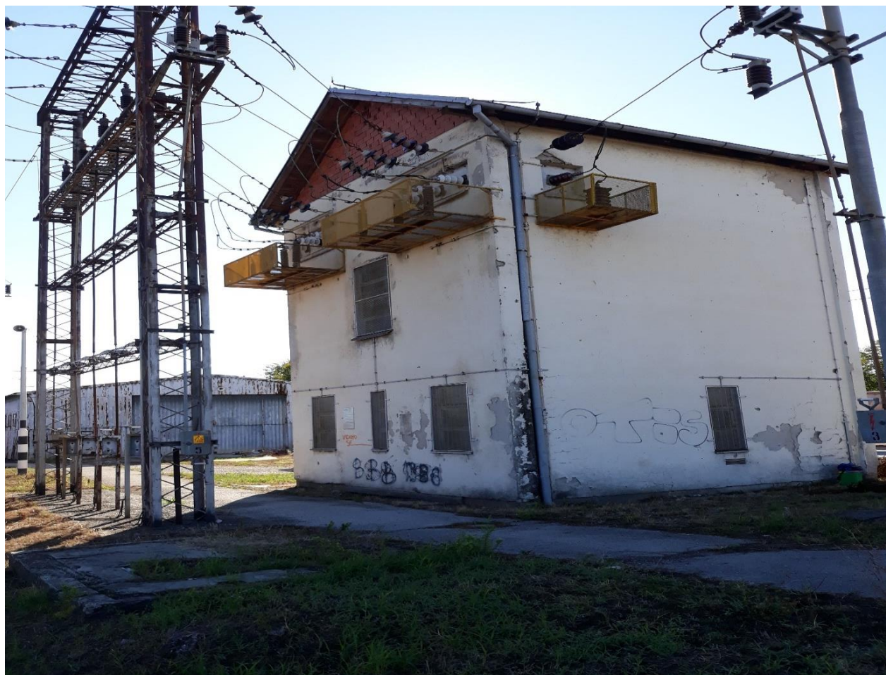
Slika 3.2 Stvarni izgled elektrovučne podstanice[6]
