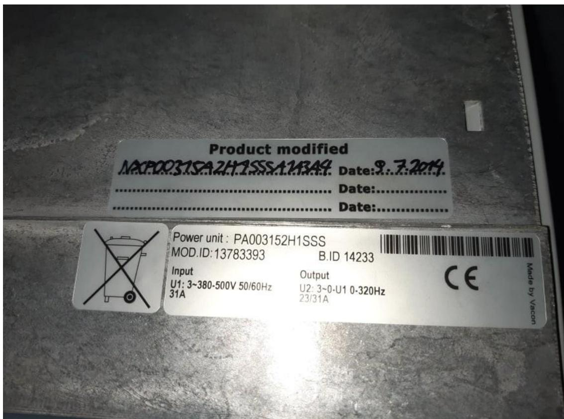
**Slika 3.2.** Natpisna pločica frekvencijskog pretvarača VACON NXP
