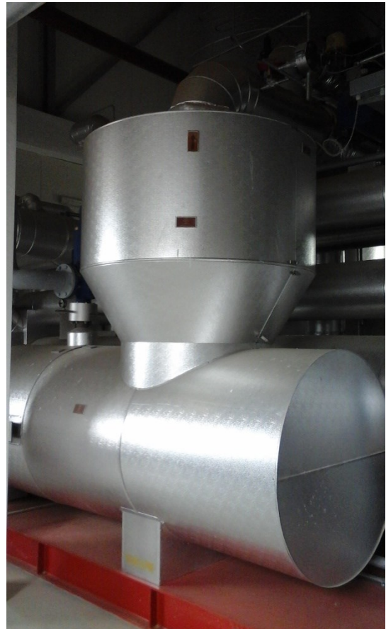
Slika 3.16. Ishlapljivač
