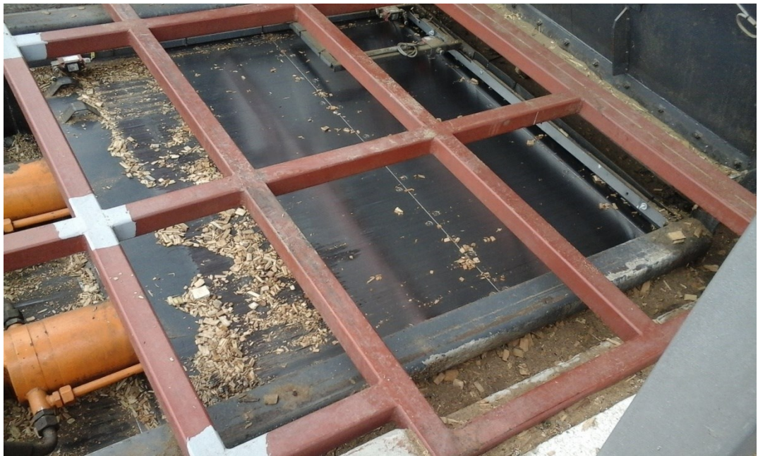
Slika 3.8. Uređaj za doziranje ubacuje sječku u kotao
