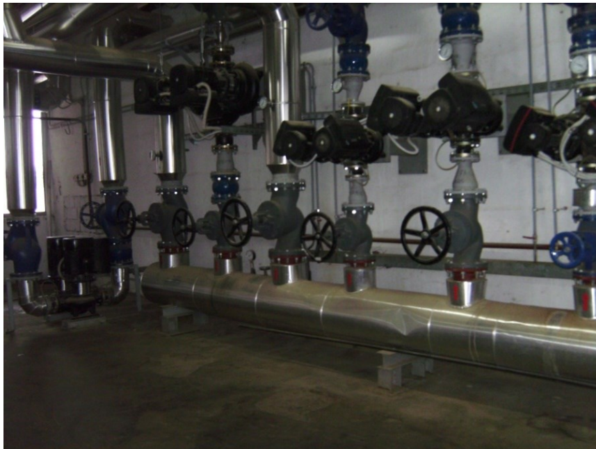
Slika 3.20. Pumpe za vodu koja ide prema potrošačima
