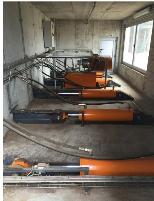
Slika 3.6. Hidraulične pumpe
