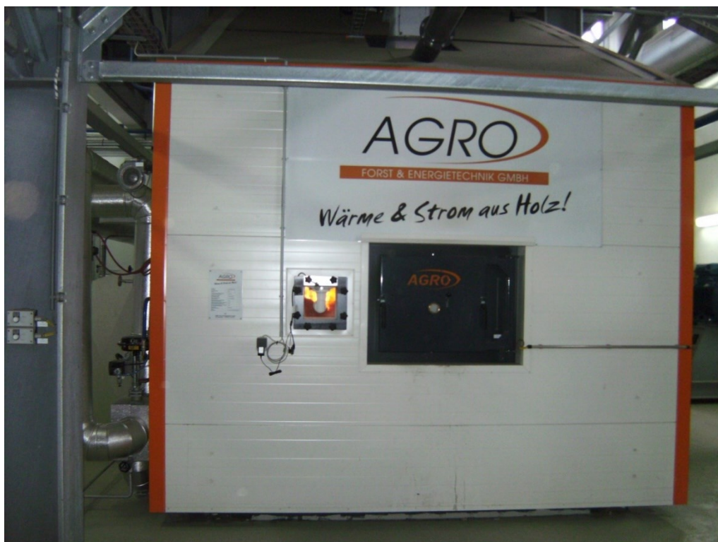
Slika 3.11. Kotao za zagrijavanje dijatermičkog ulja
