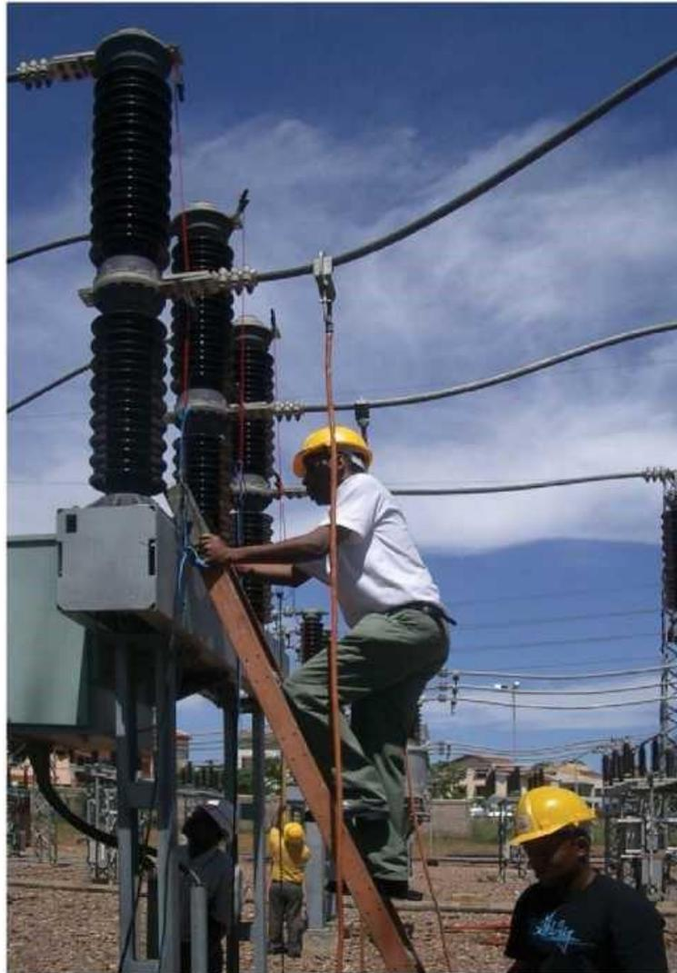
Sl.4.1. Prekidač uzemljen prilikom probe ispitivanja
