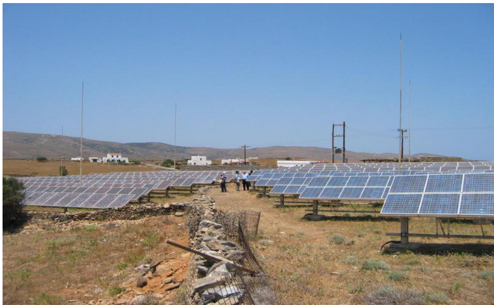
Slika 4.2. Prikaz fotonaponskih panela na otoku Kythnos [18]
