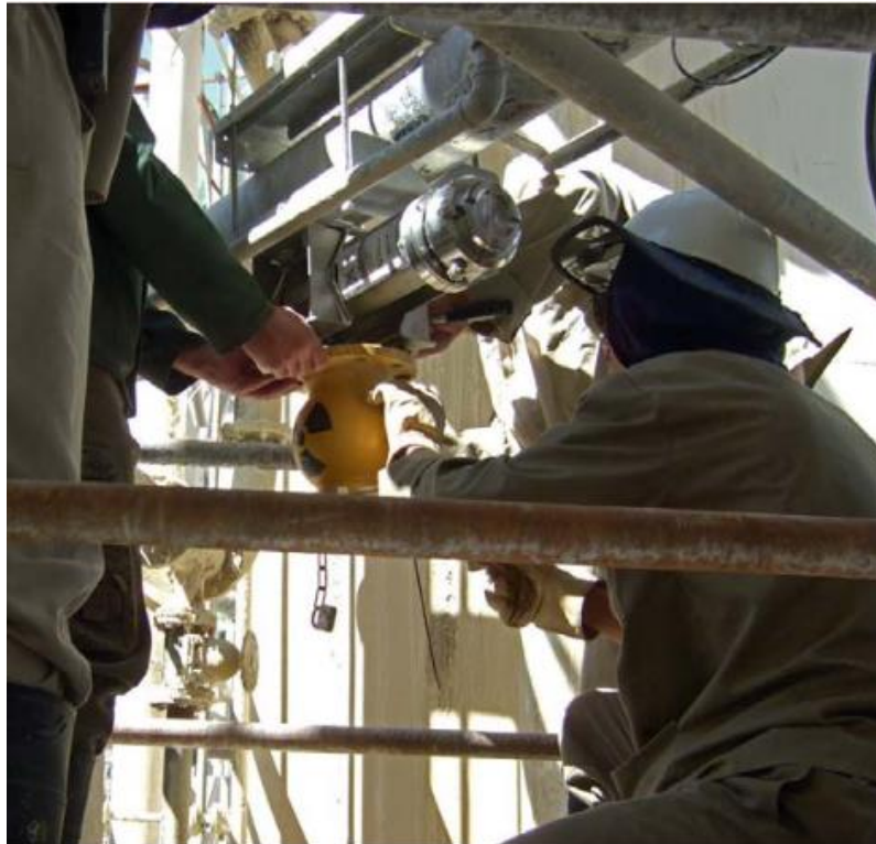
Slika 6.1. Postavljanje radiometrijskog uređaja[2]
