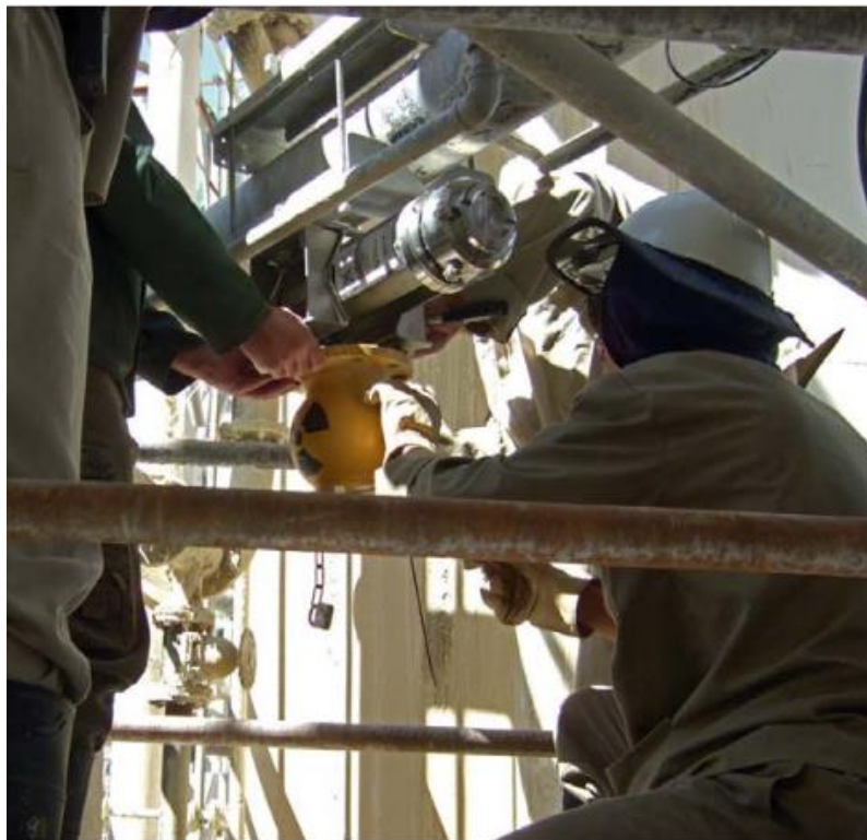
Slika 6.1. Postavljanje radiometrijskog uređaja[2]
