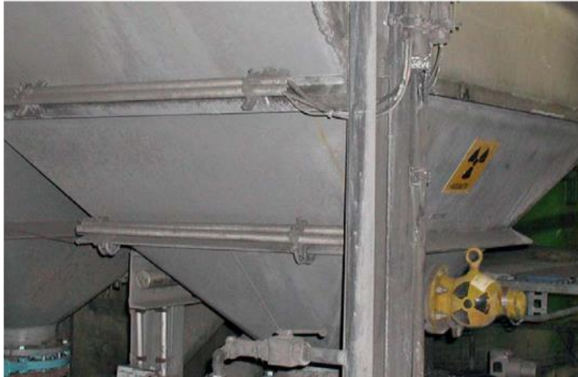
Slika 6.3. Primjena radiometrijski uređaja na raznim oblicima spremnika[2]
