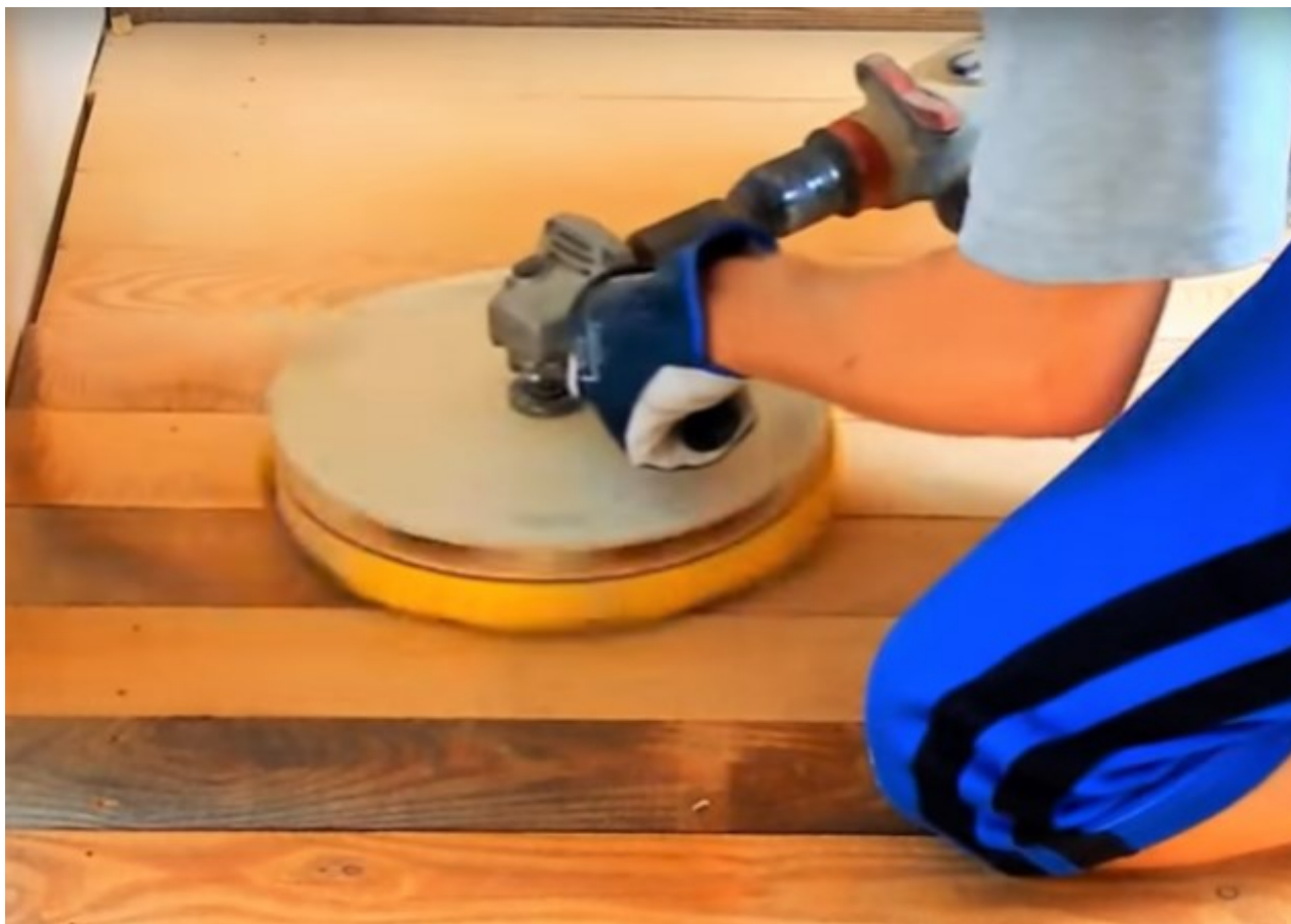
Slika 4.11. Strojno brušenje [13].
