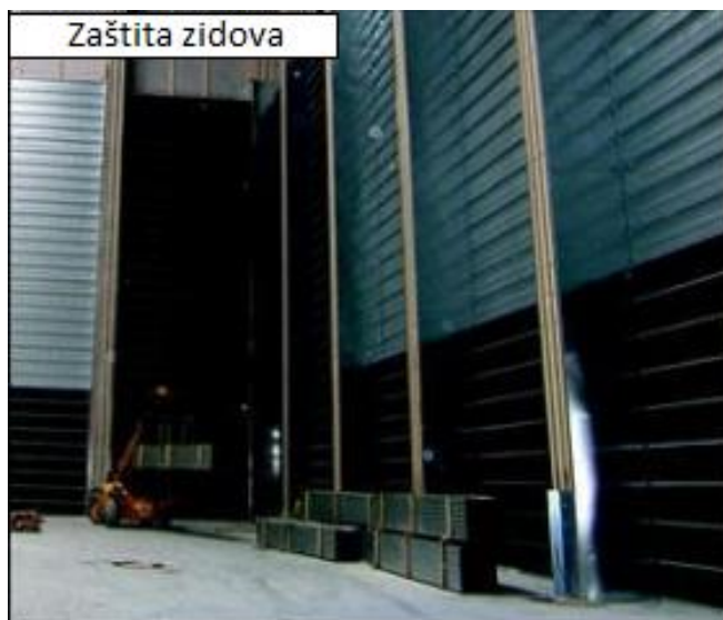
Slika 5.6. Elektromagnetska zaštita zidova.[1]
