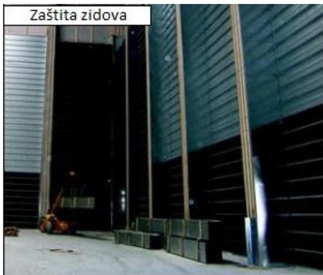
*Slika 5.6. Elektromagnetska zaštita zidova.[1]*
