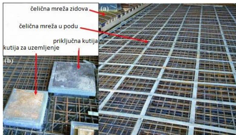
*Slika 5.5. Elektromagnetska zaštita poda [1]*
