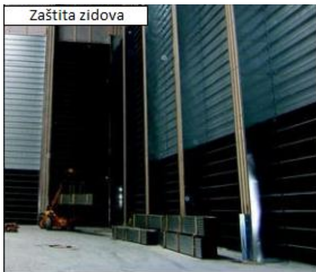
Slika 5.6. Elektromagnetska zaštita zidova.[1]
