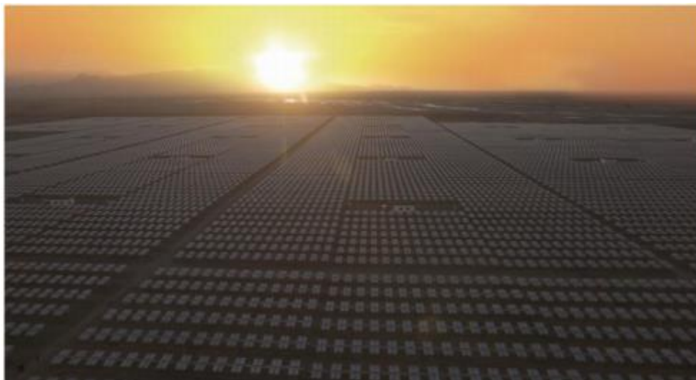
Slika 3.11. Koncentrirana fotonaponska elektrana snage 140 MW u Golmundu u Kini [11]
