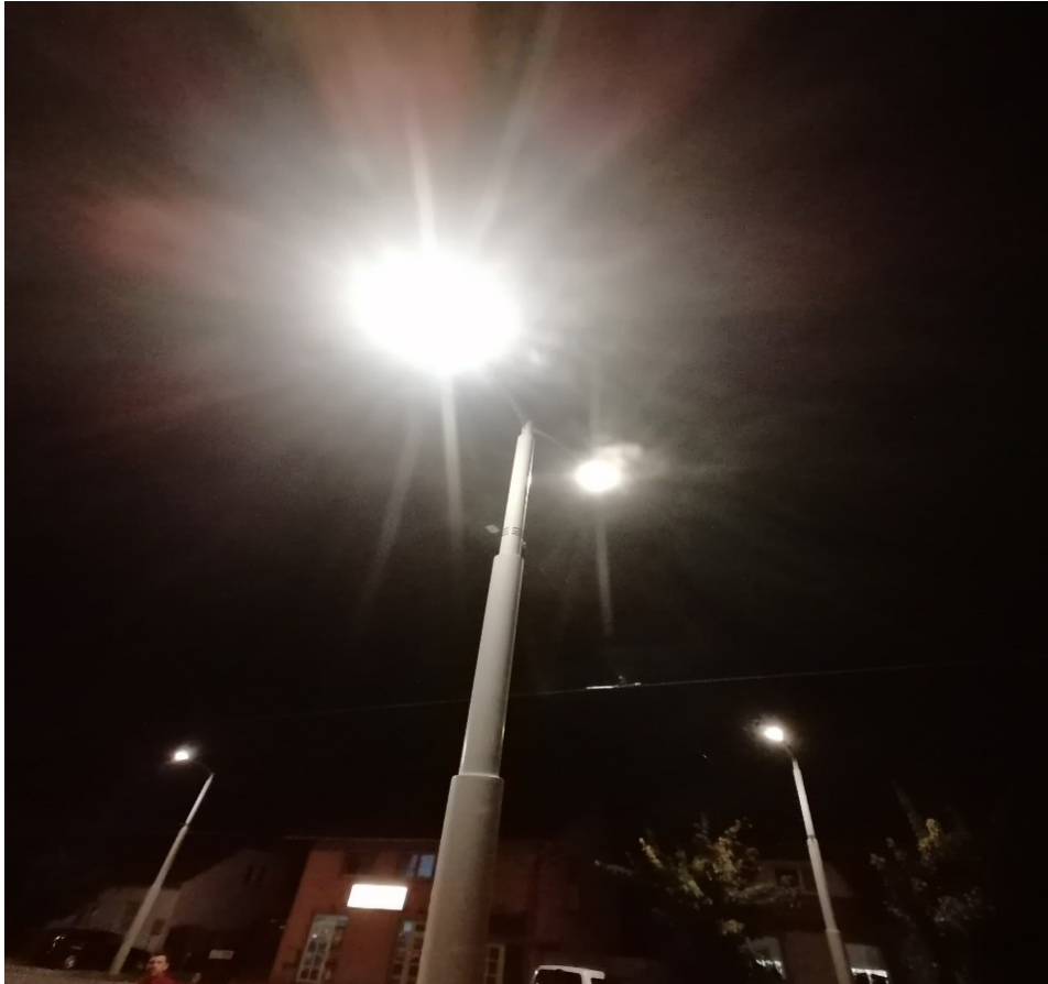
Slika 4.6: Dvostruka rasvjetna tijela na rasvjetnom stupu
