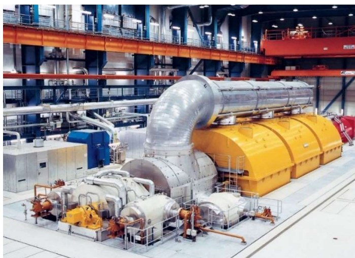
Slika 3.3 Siemens turbogenerator snage 500 MW, pokretan parnom turbinom [8]
