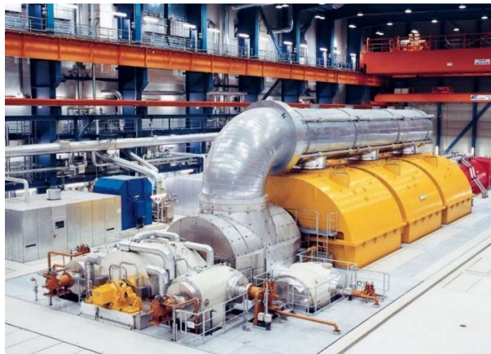
Slika 3.3 Siemens turbogenerator snage 500 MW, pokretan parnom turbinom [8]
