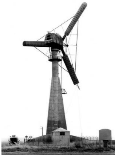
Sl. 4.11. Gedser vjetroagregat [14]
