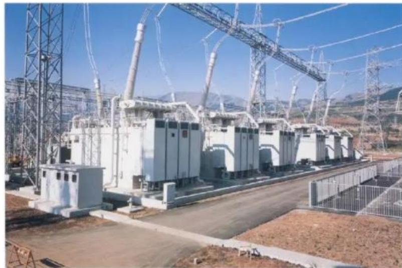
*Slika 3.8. Jednofazni autotransformator 500 MVA [10].*
