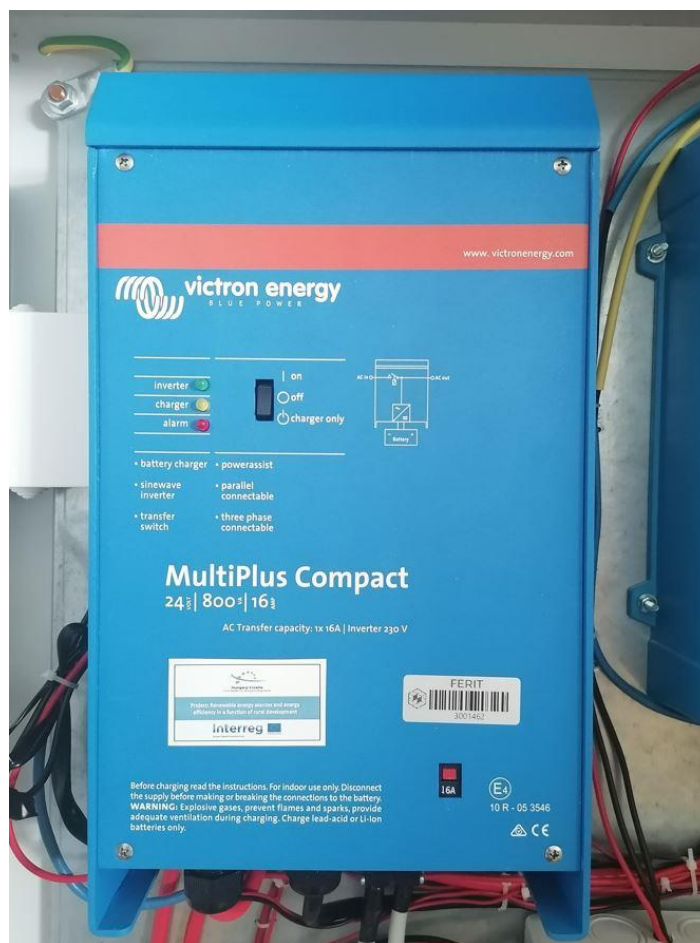
Slika 4-7 MultiPlus Compact 24 | 800 | 16 izmjenjivač/punjač
