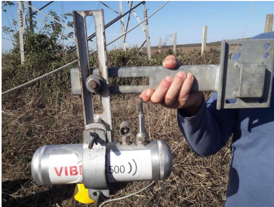
Slika 2.19. Antivibracijska prigušnica
