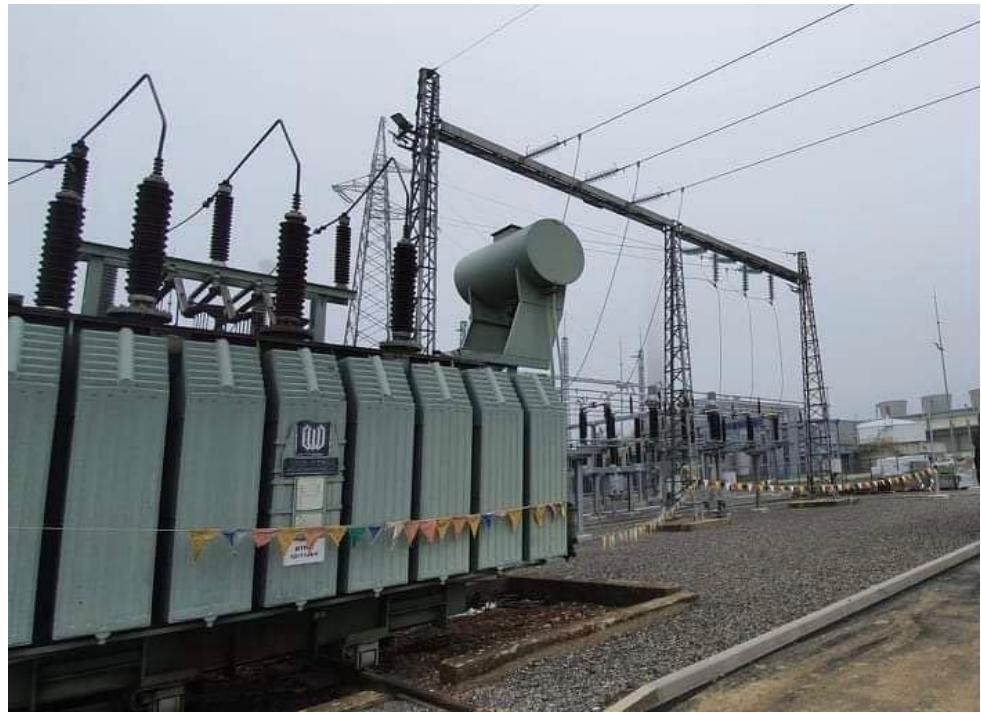
*Slika 2.8. Transformator 10/110 kV i vodno polje*
