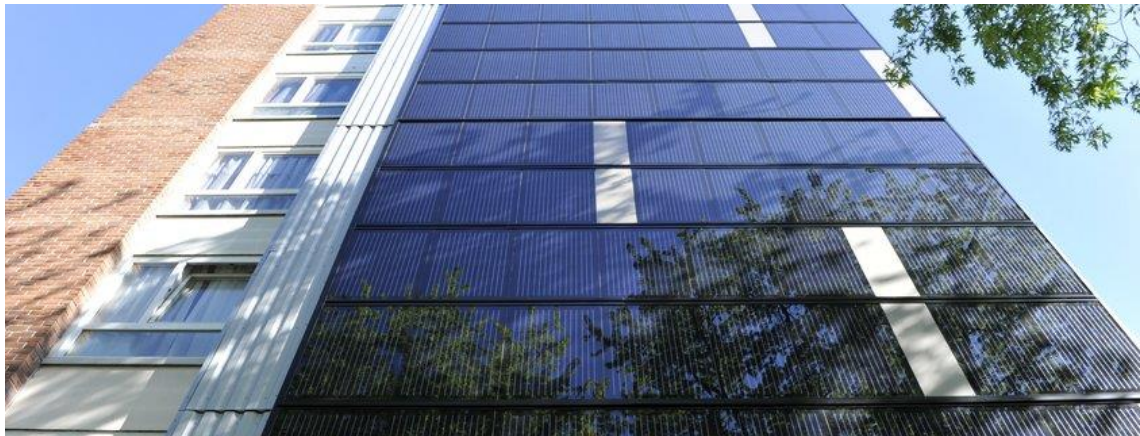
Sl. 2.13. Primjer fasadnog FN sustava [13]
