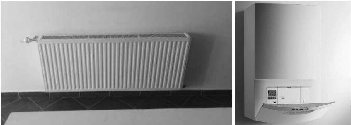
Slika 5.1: Aluminijski pločasti radijatori i fasadni kondenzacijski bojler [12]
