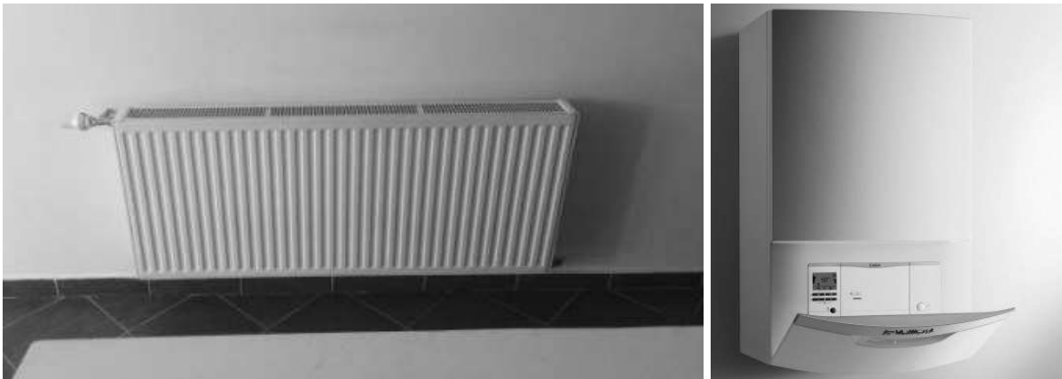
Slika 5.1: Aluminijski pločasti radijatori i fasadni kondenzacijski bojler [12]
