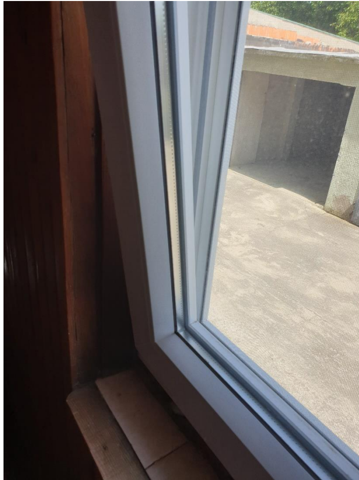
Slika 3.4. Profil prozora ukupne toplinske provodljivosti 1,4 \text{ W/m}^2\text{K} .
