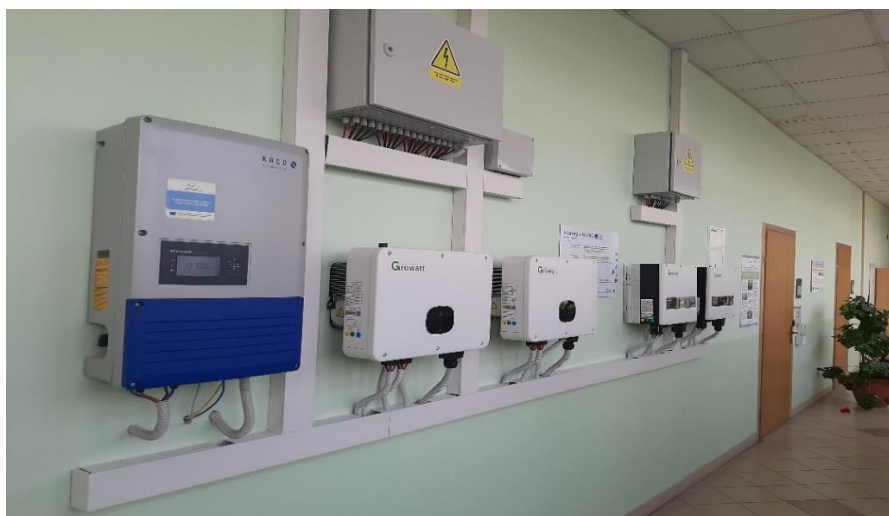
Slika 1.3. Izmjenjivači u mikromreži FERIT 1
