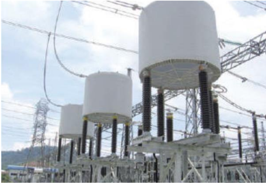
Slika 2.28. Prigušnice za ograničenje kratkog spoja [6]
