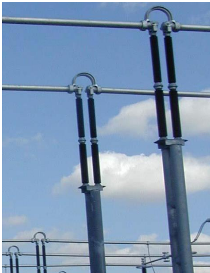
Slika 2.4. Potporni izolator 400 kV [1]
