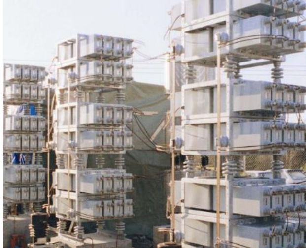
Slika 2.31. Kondenzatori [1]
