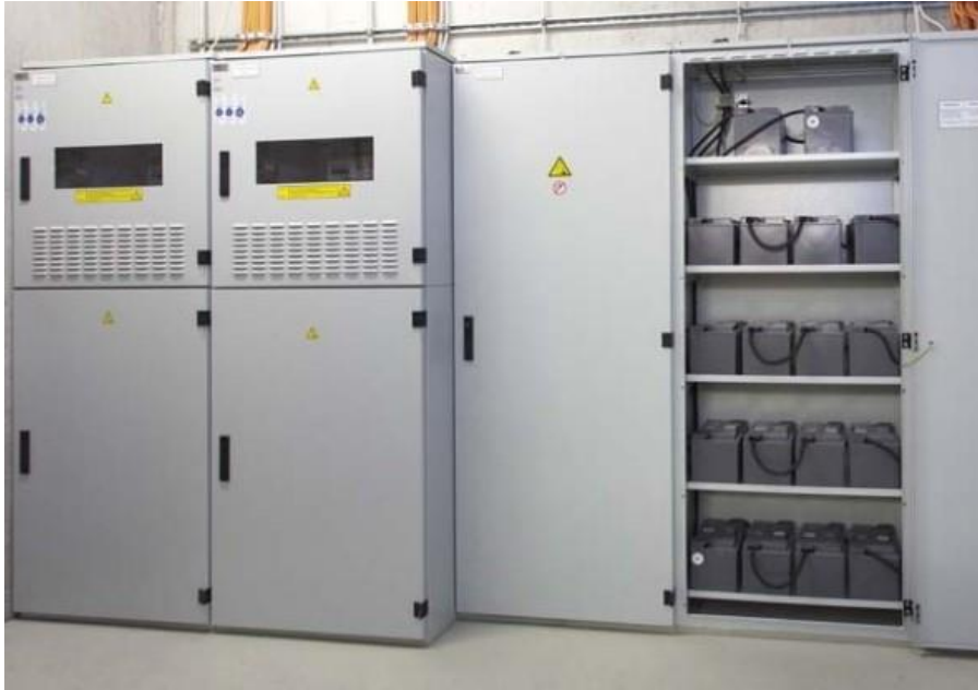
SI.4.3. Jedinica sustava centralnog napajanja [6]
