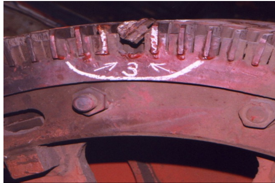
Slika 5.2. Oštećenje kaveznog rotora
