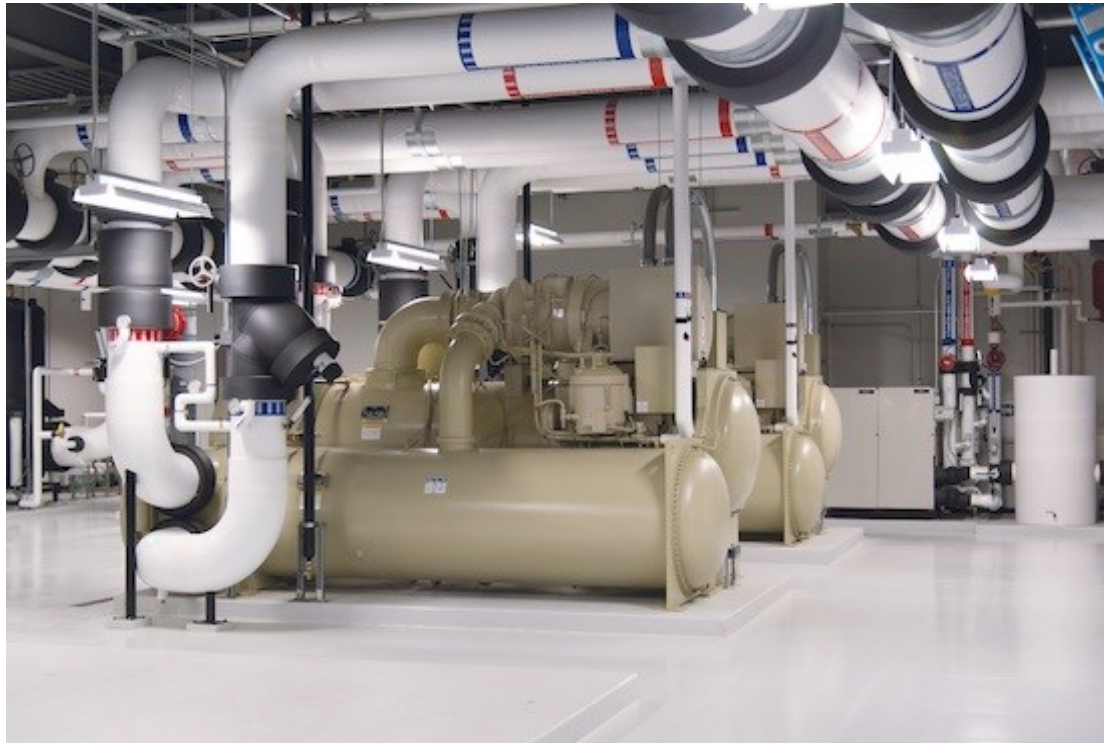
Slika 3.4.2. Prikaz vodom rashladnog uređaja u većim postrojenjima
