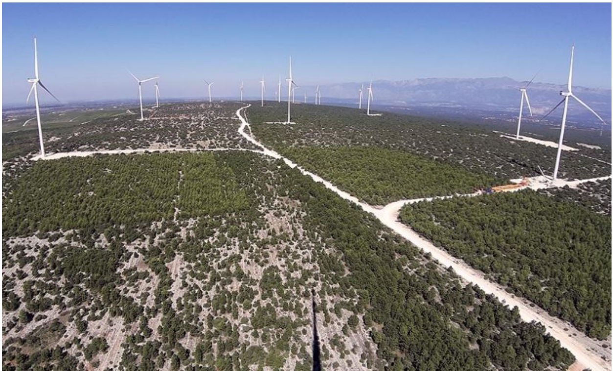
Sl. 3.3. Vjetroelektrana Korlat[14]
