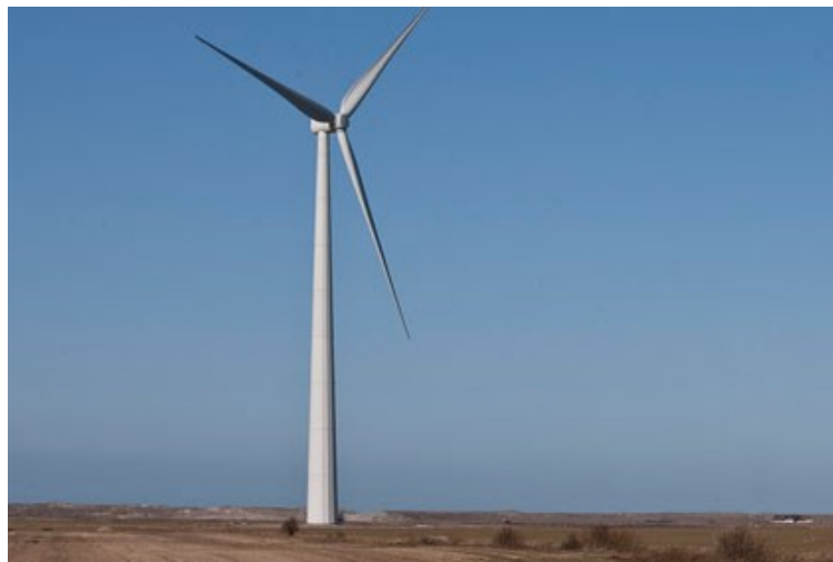
Slika 4.1.1.1. Primjer cijevne izvedbe stupa vjetroagregata [15]
