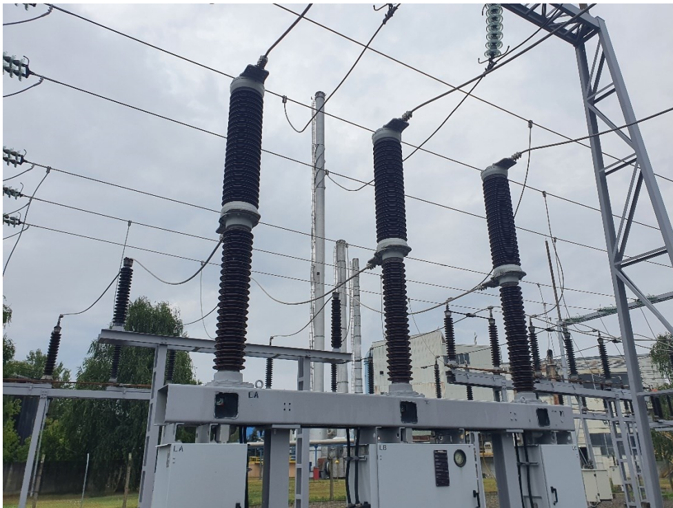
Slika 6.8. Odabrani SF 6 prekidač tip 3AP1FE(FG) (fotografirano 9.kolovoza 2022.)
