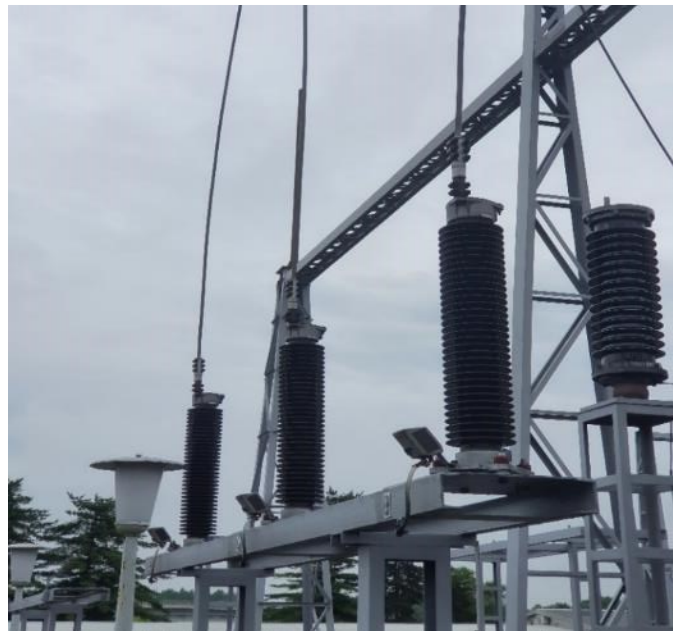
Slika 5.3. Odvodnici prenapona (fotografirano 9. kolovoza 2022.)
