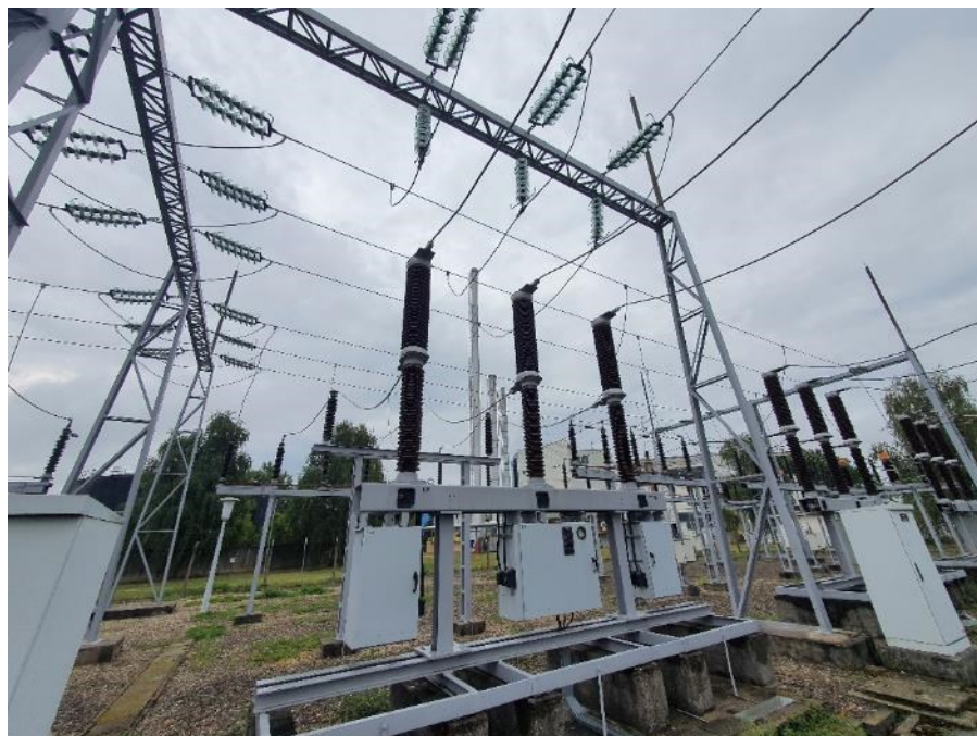
Slika 5.6. SF_6 prekidač (fotografirano 9. kolovoza 2022.)
