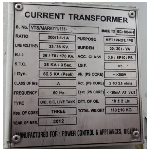
Sl. 4.10 . Natpisna pločica strujnog mjernog transformatora. [19]
