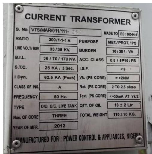
Sl. 4.10 . Natpisna pločica strujnog mjernog transformatora. [19]
