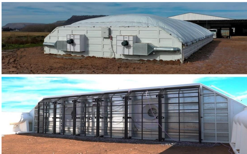
Slika 6.8. Pametno prijenosno skladište za krumpir sa sustavom ventilacije
