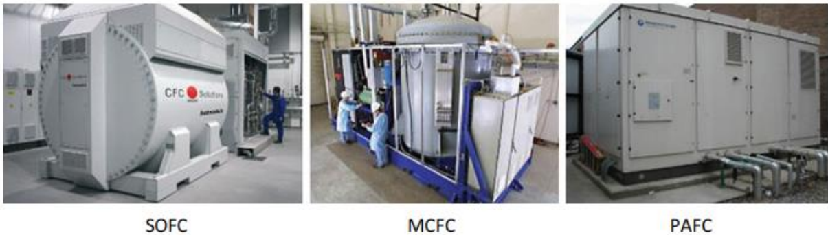
Slika 4.4.3.Kogeneracijske jedinice s različitim vrstama gorivih ćelija [15].
