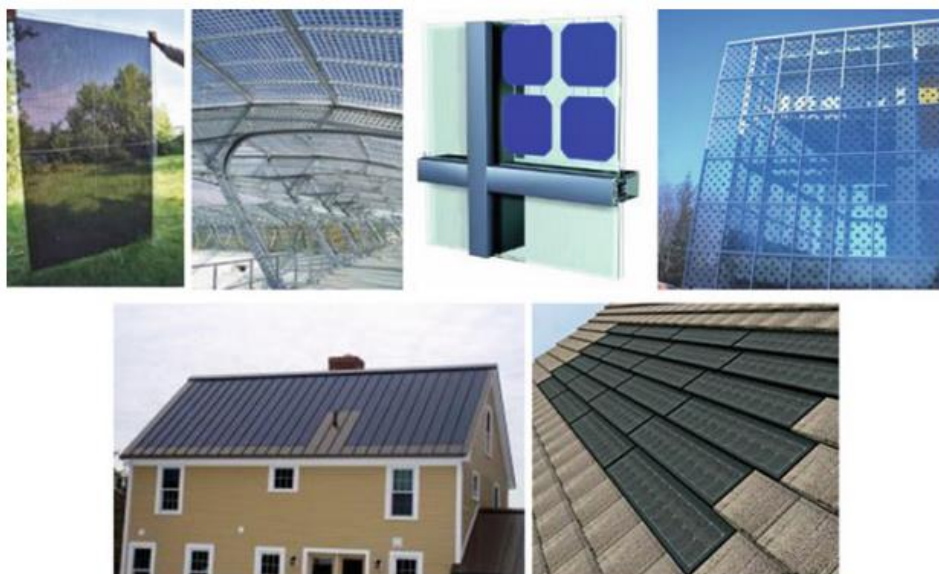
Slika 4.1.3.1. Prikaz različitih rješenja integracije FN modula [15].
