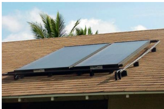
Slika 3.6.6. Pločasti kolektor [21].
