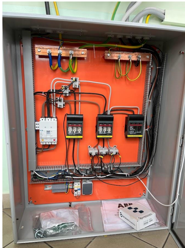
Slika 4.3. Strujni mjerni transformatori
