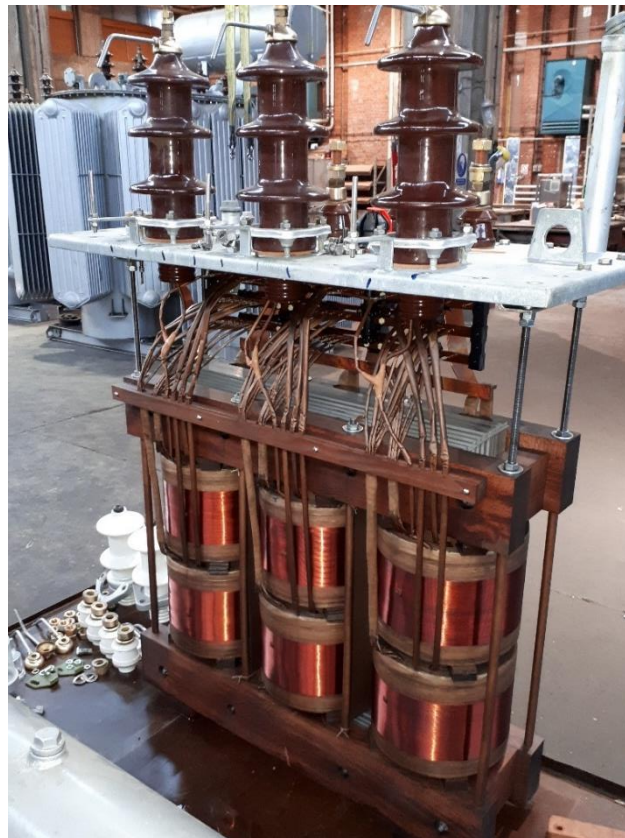
Sl. 3.11. Prikaz unutrašnjosti distributivnog transformatora
