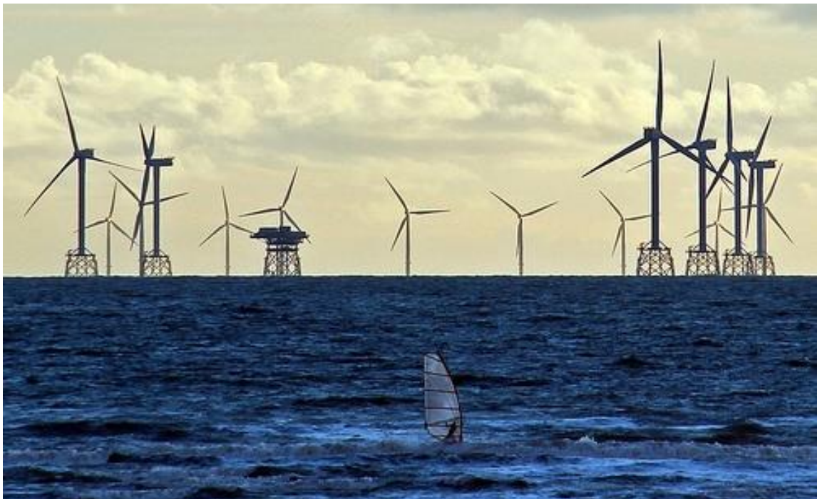
Sl. 4.8. Vjetroelektrana na pučini u Walney-u, Engleska [17]
