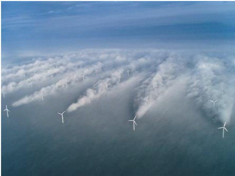
Sl. 4.12. Efekt međusobnog zaklanjanja (zavjetrine) [21]
