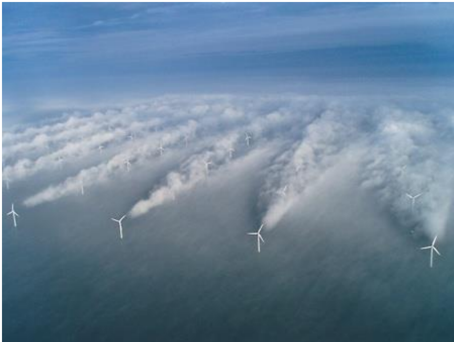
Sl. 4.12. Efekt međusobnog zaklanjanja (zavjetrine) [21]
